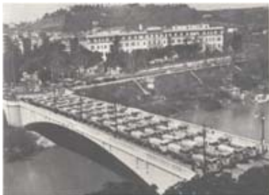
1967. Prova di carico del ponte del Risorgimento, con 56 autobotti cariche. Sempre ottimi risultati.
