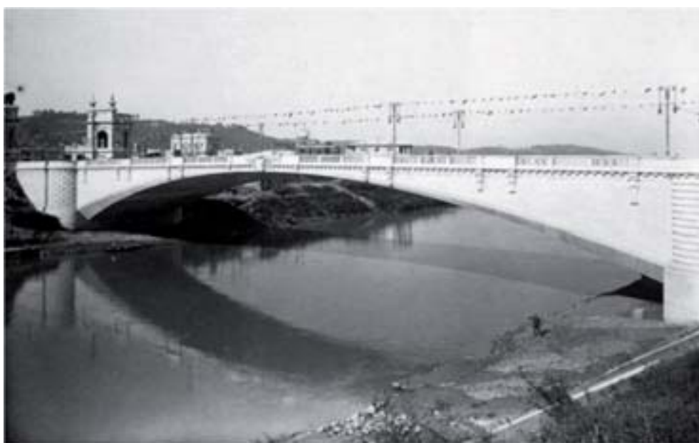
1911. Il Ponte del Risorgimento dopo lo smantellamento della centinatura in Cemento Armato ed alla apertura al traffico veicolare anche pesante. La sagoma di un tram si intravede dietro il parapetto del ponte.
