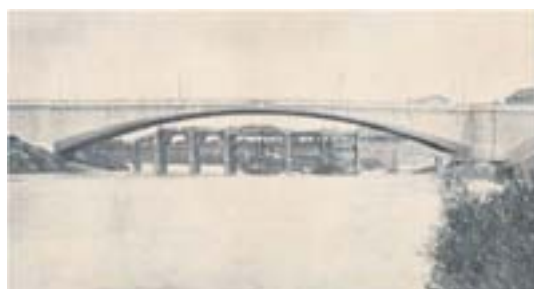
1911. Ponte del Risorgimento. Vaporetto della Navigazione Fluviale che passa nella campata centrale della impalcatura provvisoria in telai iperstatici in c.a..
