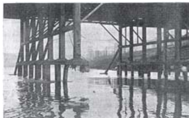
1909. Il ponte del Risorgimento in costruzione. Intelaiatura iperstatica in c.a. Il 29 dicembre il vaporetto Eugenia della Società Navigazione Fluviale investe una delle stilate centrali dell'impalcato provvisorio ed alcuni dei pali in cemento armato vengono spezzati. Nessun danno alla restante struttura a telaio in c.a. Il vaporetto cola rapidamente a fondo.
