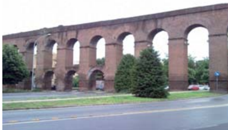
fig.2 - Vista generale dell'Acquedotto Alessandrino su V.le P.Togliatti: si notino i fornici di sinistra (verso Est) che hanno 2 piani, uno in basso e uno a mezza quota, questo si propone di utilizzare per la monorotaia (2° e 3° fornice doppio, sottoutilizzati nel piano basso), con ovvio vantaggio per l'impatto visivo, quasi nullo, lasciando il monumento integro.
